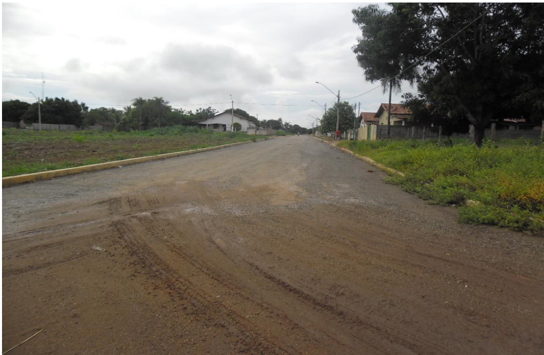
RUA 01 (RUA PAVIMETADA TP 006/2008).
